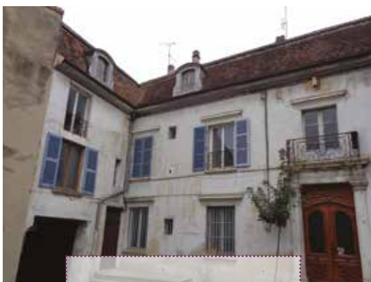
↑ Réalisation de travaux à Ambérieu en Bugey. Avant travaux, après travaux.
